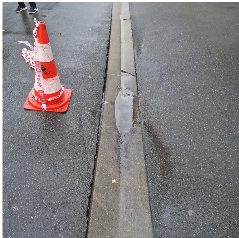
Affaissement de plusieurs centimètres avec fissuration de l'enrobé.
