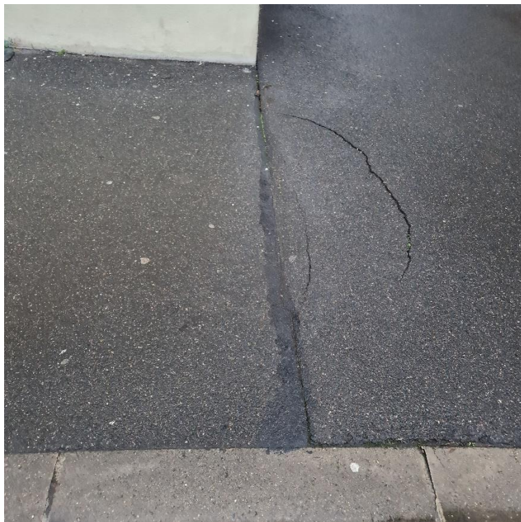
Affaissement de plusieurs centimètres avec fissuration de l'enrobé.
